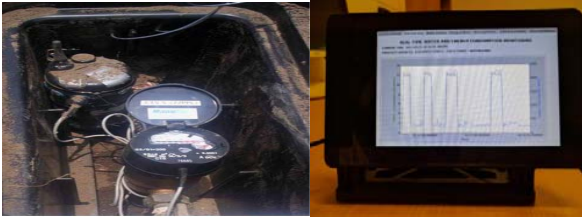
(c) Smart water meter (d) Raspberry pi with display
